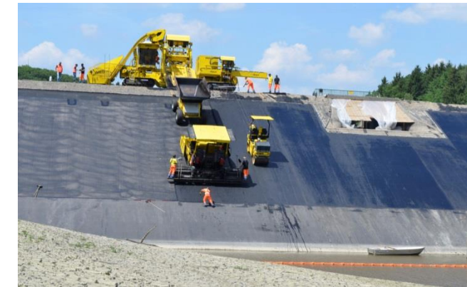
Aufbringen der neuen Dichtungslage mittels Asphaltfertiger
