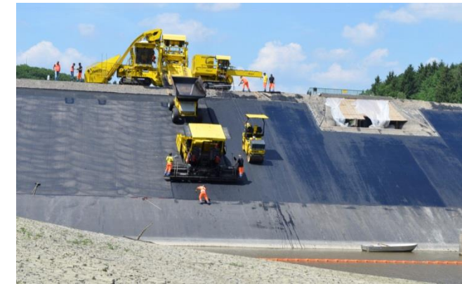
Aufbringen der neuen Dichtungslage mittels Asphaltfertiger
